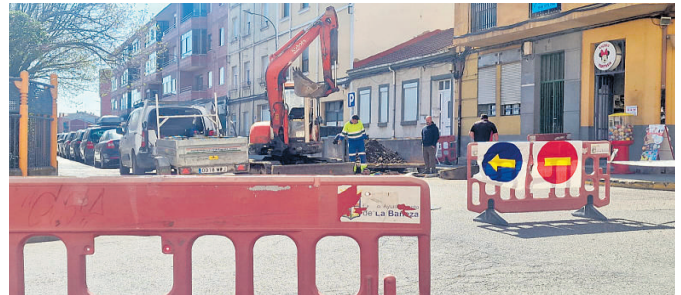
Obras de detección de fugas de agua en La Bañeza. L.N.C.
